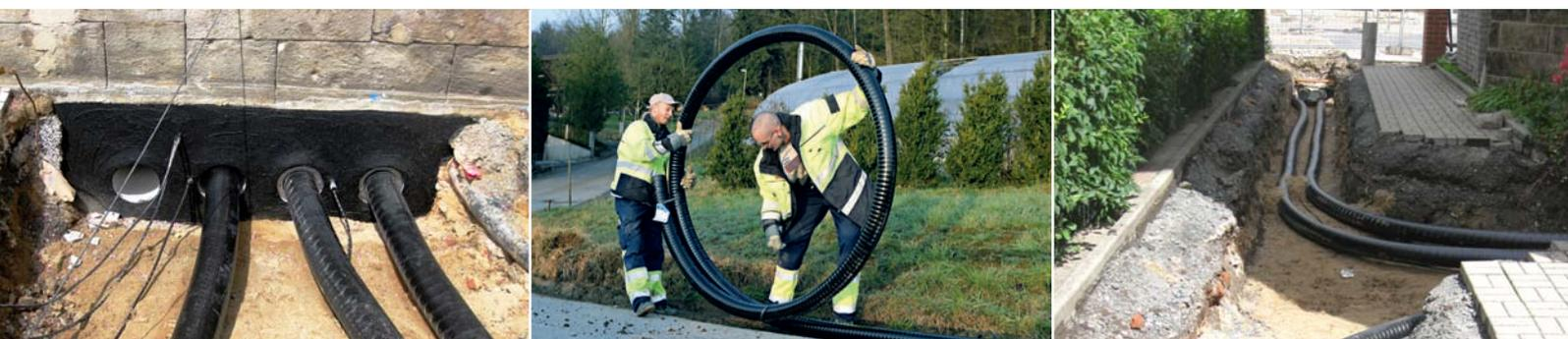
**CASAFLEX è un sistema di tubazione flessibile, autocompensante, monitorabile, con isolamento termico, in acciaio inox, disponibile nelle varianti UNO e DUO, disponibili con notevoli lunghezze in unica tratta.**
